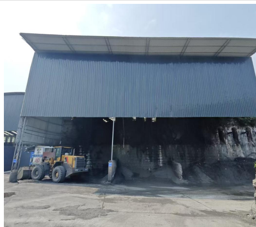
煤矸石洗选车间外西北侧白矸石堆场 （5~10mm、10~20mm、20~30mm）
