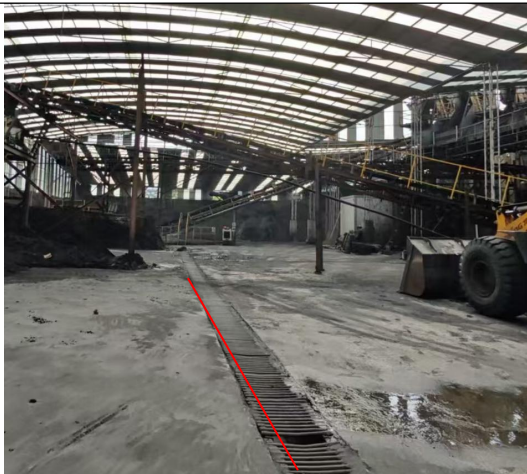
煤矸石洗选车间截排水沟
