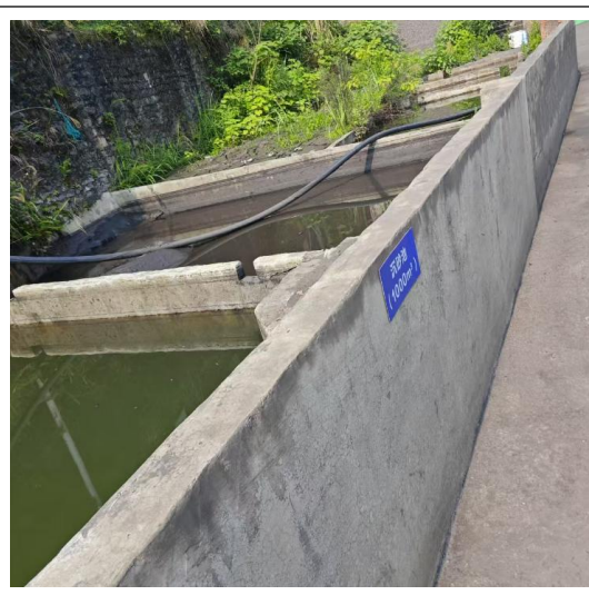
煤矸石洗选车间外北侧沉淀池（1000m 3 ）
