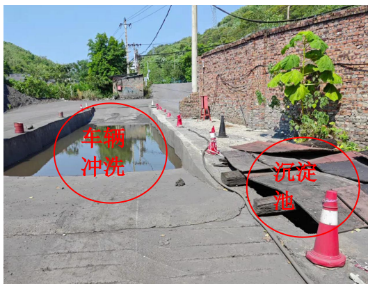
车辆冲洗槽+沉淀池（30m³）
