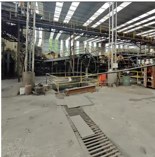
煤矸石洗选车间截排水沟、沉淀池（80m 3 ）
