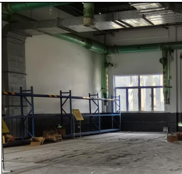
甲类仓库（内部）
