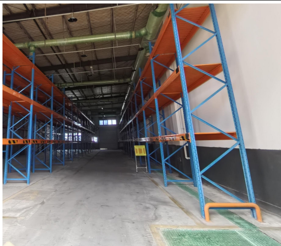
收集沟、收集池
