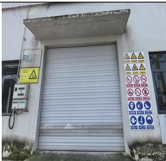
甲类仓库（外部）
